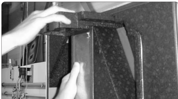
Figuur 14.2 Verwijderen van de vulplaat.
