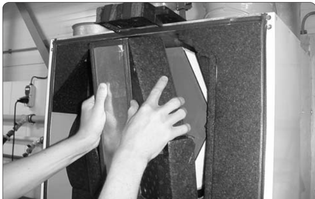
Figuur 14.3 Verwijderen bypass.
