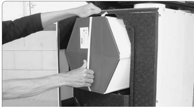
Figuur 14.4 Verwijderen van de warmtewisselaar.
