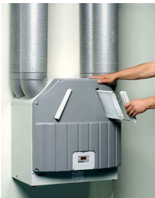
Filterhouders verwijderen
