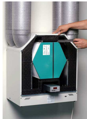
Warmtewisselaar losmaken
